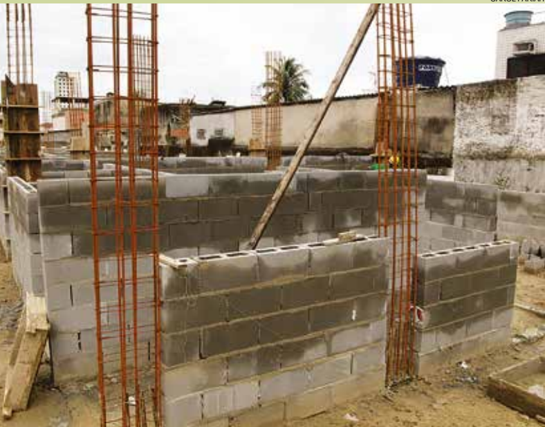
Paredes são erguidas e revelam a divisão dos espaços da futura unidade
