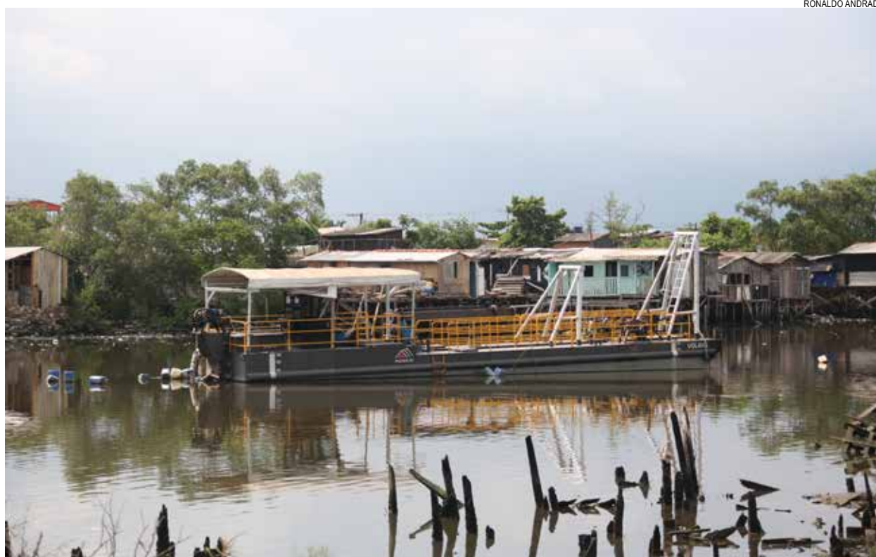
Dragagem do Rio São Jorge integra a segunda fase do programa e já alcançou 85% dos trabalhos previstos
