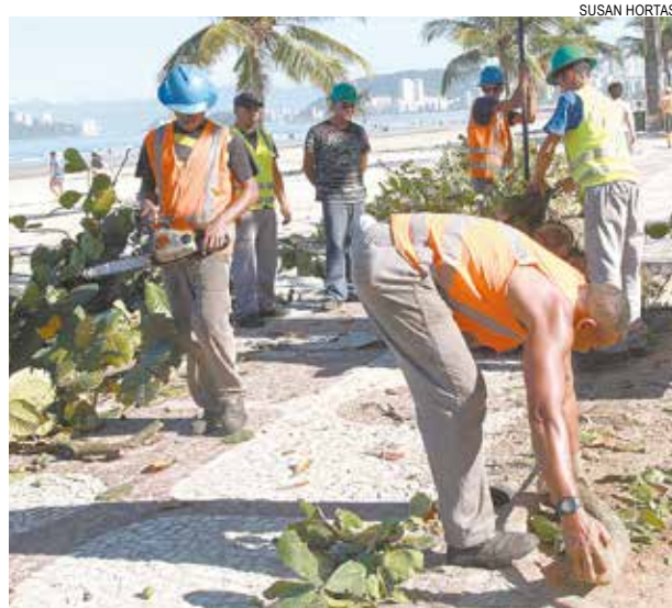
Operários fazem o corte do vegetal e limpeza da área
