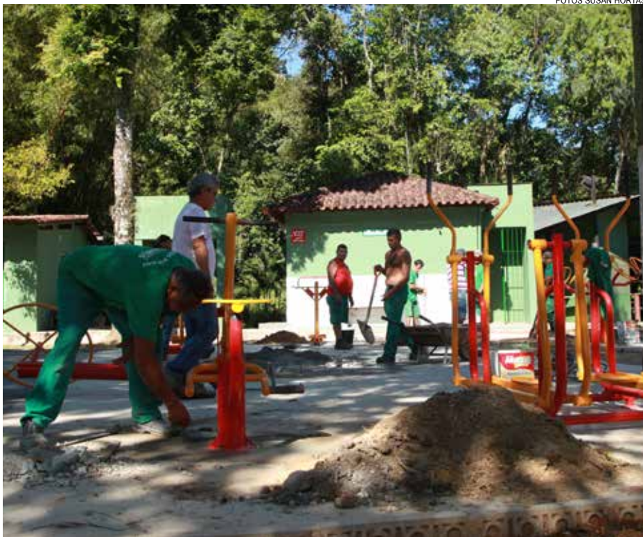
Uso deve ser liberado na próxima semana, após secagem completa dos equipamentos
