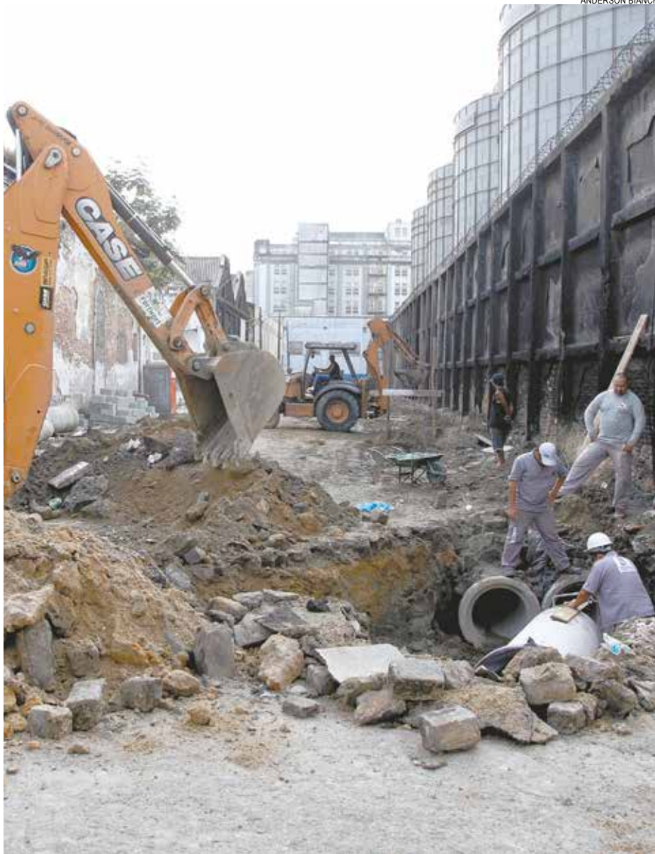
Obra na Rua Dr. Cóchrane é feita em parceria entre Prefeitura e iniciativa privada
