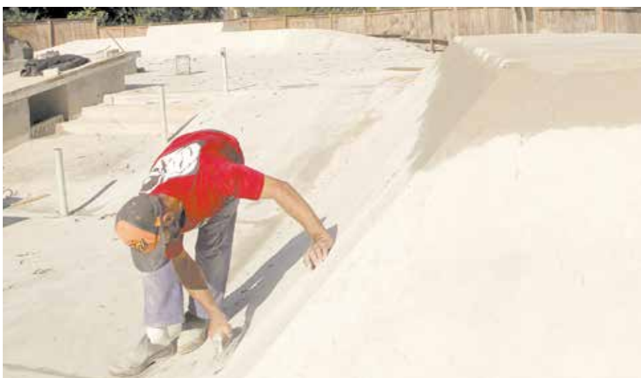
Operários executam o lixamento do piso para que seja aplicada a resina
