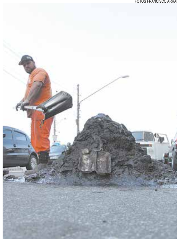
Lama é removida de boca de lobo e ramal de ligação
