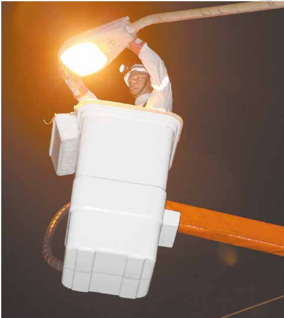
Equipes da empresa contratada pela Prefeitura executam os trabalhos nas vias
