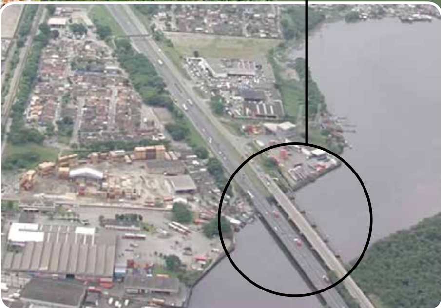
Duplicação da Ponte do Rio Casqueiro
