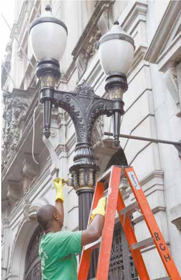
Postes de iluminação recebem nova pintura
