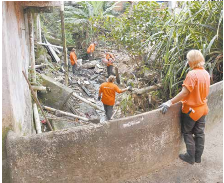
Funcionários se dividiram em duas frentes para retirar entulho de córrego
