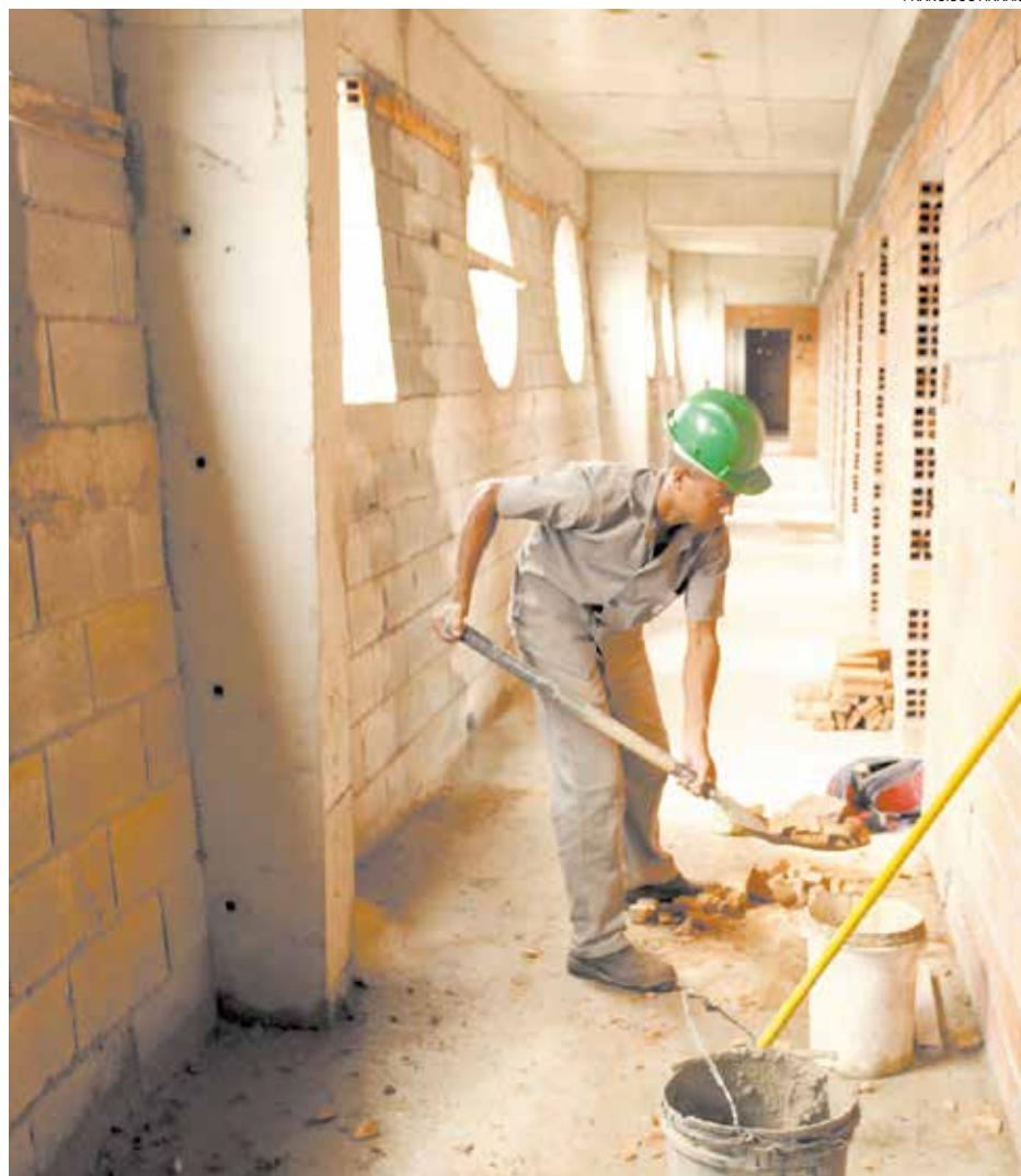
Trabalhadores estão concentrados na execução da arquibancada e piso da quadra
