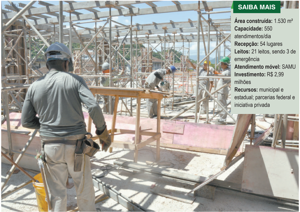
Operários estão concentrados na execução de 33 pilares que vão sustentar a estrutura do piso superior
