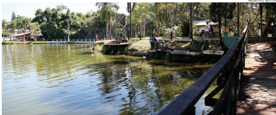
Prefeitura realizará serviços de recuperação na calçada após trecho sofrer erosão
