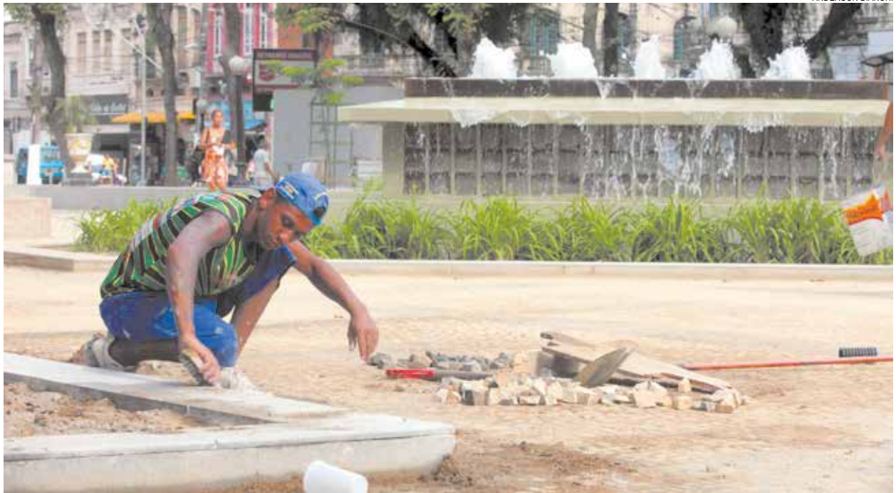
A colocação de mosaico português próximo à estação do bonde faz parte dos trabalhos finais em execução
