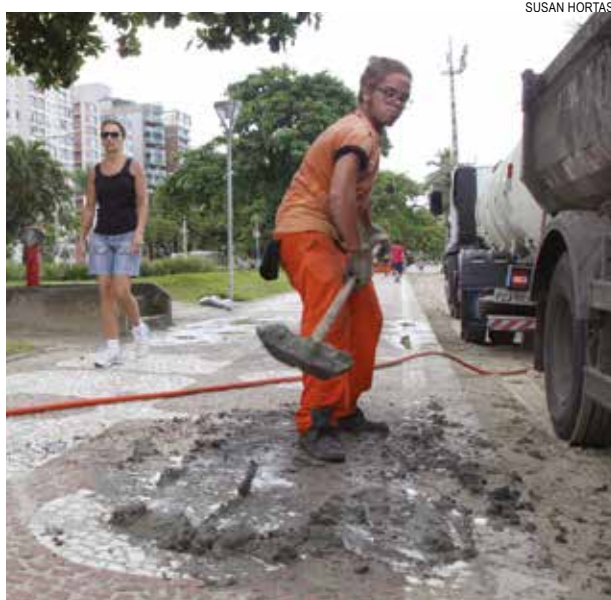
Trabalho é feito com apoio de caminhão de hidrojateamento
