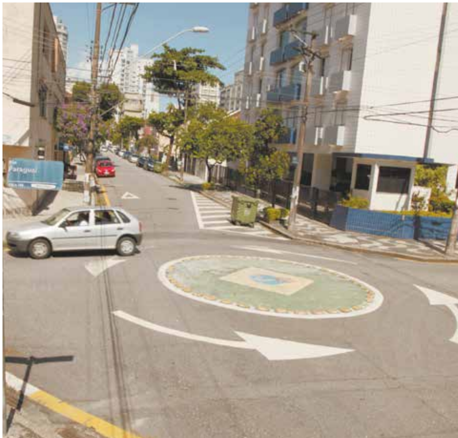
Equipamento organiza circulação de veículos onde não se justifica colocar semáforo
