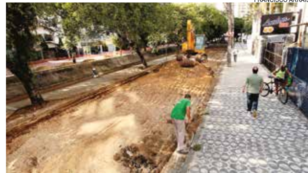
Paralelepípedos são removidos para colocação de asfalto
