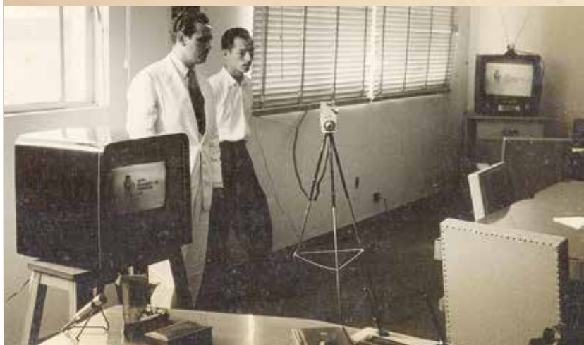
Teste do circuito fechado nas dependências da Rebratel, no Edifício Rubiácea
