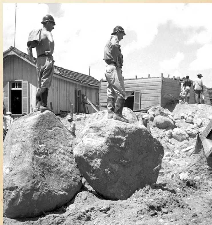
Esses dois bombeiros, dos muitos que foram convocados para o serviço de remoção de escombros, trabalharam dedicadamente, dia e noite, sobre enormes pedras, que se deslocaram da calota granítica do morro de Santa Terezinha e se precipitaram sobre os chalés situados na sua encosta, provocando muitas mortes.
