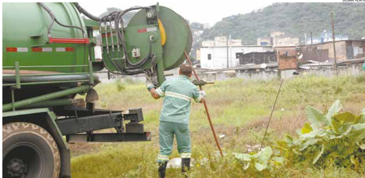
O terreno, que ontem já recebeu serviços para desobstrução de rede de esgoto, também terá melhorias na drenagem
