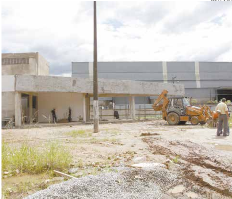
Operários trabalham nas partes elétrica e hidráulica e na implantação de revestimentos
