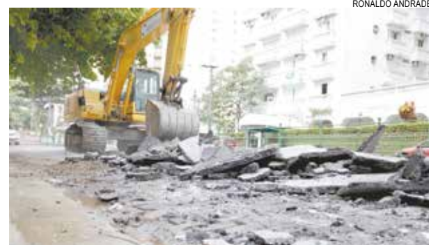
Trabalhos ocorrem entre a Avenida Epitácio Pessoa e a orla
