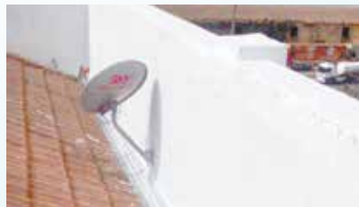
Impermeabilização no Museu Pelé, Valongo
