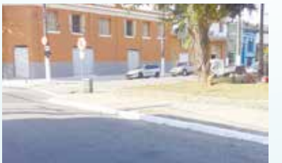
Pintura de guias, postes e mureta do canal da Campos Salles, Vila Nova
