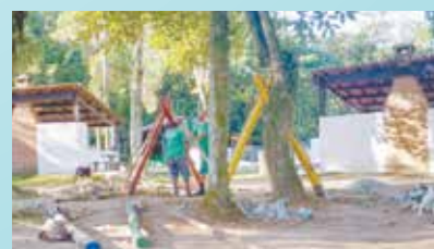
Manutenção de brinquedos da Lagoa da Saudade (Morro Nova Cintra)
