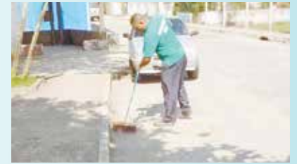
Limpeza da Rua Principal no Monte Cabrão
