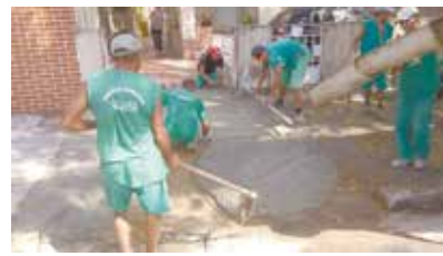
Concretagem executada na Rua Armando Sales de Oliveira - Boqueirão
