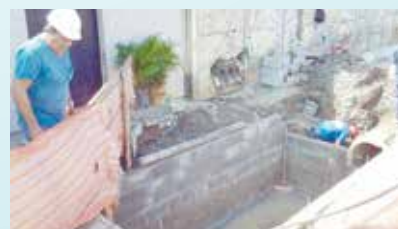
Construção de caixa de retenção de sólidos no bairro Caneleira
