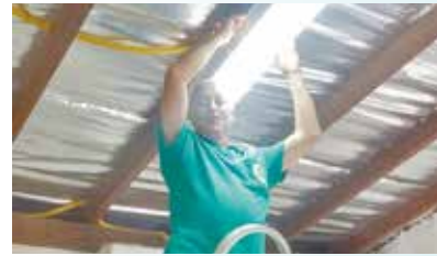
Manutenção elétrica na UME Noel Gomes Ferreira, Caruara
