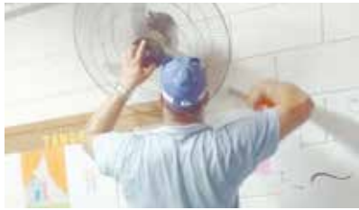
Troca de ventiladores e lâmpadas na UME Monte Cabrão
