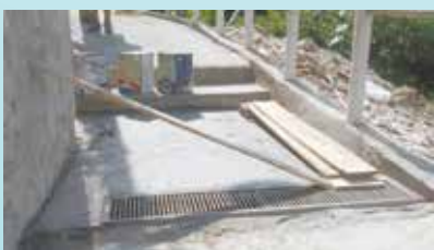
Manutenção em escadaria - Rua São domingos - Morro Sao Bento
