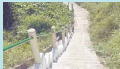
Pintura de corrimão e escadaria na Rua São Clóvis - Morro São Bento
