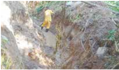
Limpeza do valão de escoamento da água pluvial, Travessa Antonio Mineiro - Caruara
