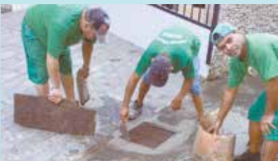
Limpeza de drenagem e colocação de grelhas na Rua Caminho das Pedras - Morro São Bento
