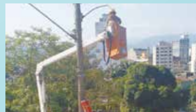
10 luminárias trocadas - Morro do Fontana
