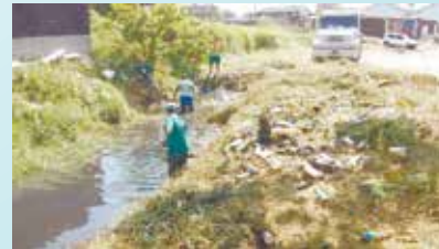
Limpeza do canal, corte de mato e retirada de lixo da Última Ponte na Vila Telma
