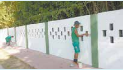
Continuação da pintura do muro do Jardim Botânico - Bom Retiro
