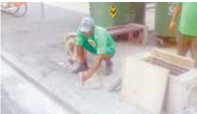
Reparo em piso e floreira na Av. Ana Costa em frente às Lojas Americanas - Gonzaga
