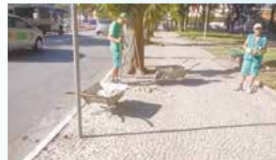
Reparos em mosaico e cordonel na Praça Aparecida - Aparecida
