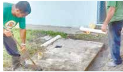
Manutenção na caixas de esgoto, UME Judoca Ricardo Sampaio - Caruara
