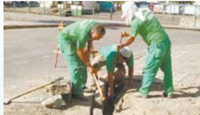
Construção de rampa de acessibilidade em frente à UBS Vila Nova
