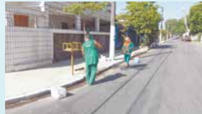
Pintura de postes e guias na Rua João Fraccaroli - Bom Retiro
