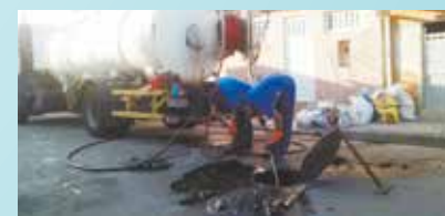
Limpeza de galerias Rua Aguinaldo Caiado, Castelo
