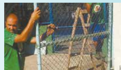
Manutenção do Portão de Entrada da UME Judoca Ricardo Sampaio - Caruara
