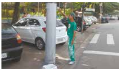
Pintura de guias e postes da Epitácio Pessoa
