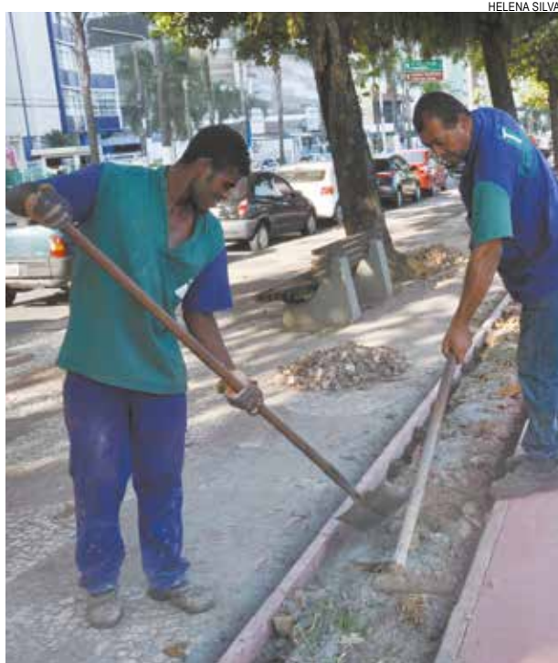
Obra prossegue entre trechos dos canais 4 e 5 e 1 e 2
