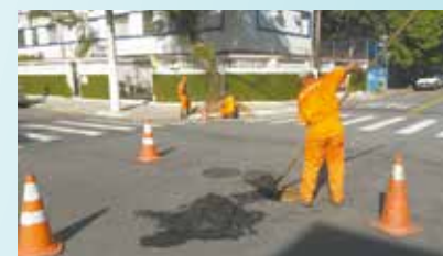
Limpeza de galeria na Rua 1º de Maio - Aparecida
