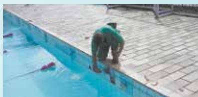
Substituição de revestimentos na piscina do Conjunto Poliesportivo M. Nascimento - Bom Retiro
