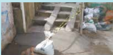
Rampa finalizada - Rua 7 - Morro José Menino
