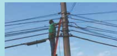
Retirada de caixa de luz - Rua Santo Antônio do Valongo - Morro São Bento
