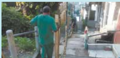
Manutenção em escadaria - Rua São Domingos - Morro São Bento
