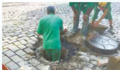
Renovimento de poço de visita na Rua Martim Afonso com Praça da República - Centro
