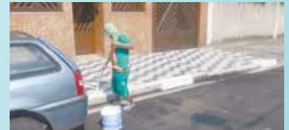
Pintura de postes e guias na Rua Bulcão Viana - Rádio Clube
