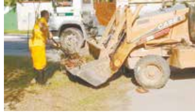
Operação Cata Treco nas ruas - Caruara
