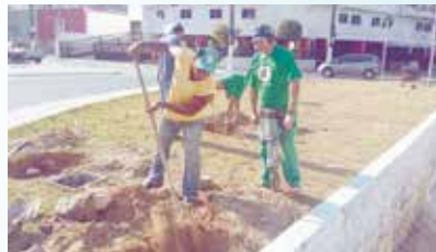
Escavação para abertura de cova no jardim do Canal 7 X Rua Rei Alberto - Ponta da Praia
