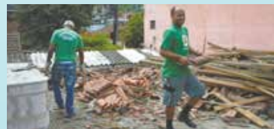
Retirada de telhas da Creche Solar dos Anjos - Nova Cintra
