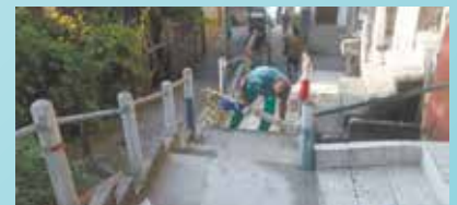
Continuação de manutenção da escadaria São Domingos - São Bento
