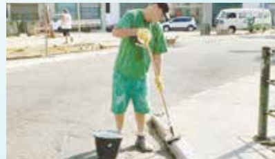
Continuação da pintura de poste e guias na Vila Nova
