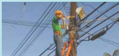
Troca de lâmpadas em refletores em toda a extensão da Av. Santista - Nova Cintra
