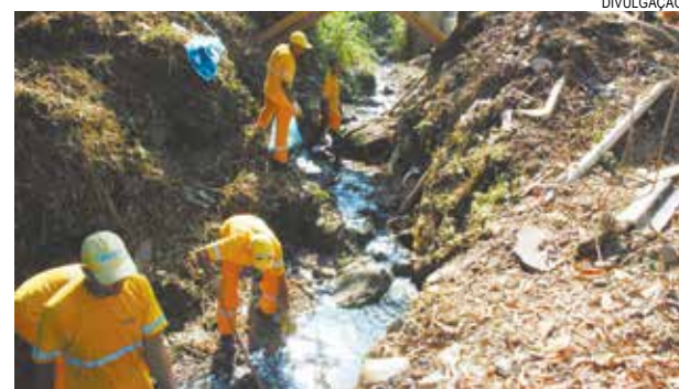
Equipe retira os detritos depositados em córrego
