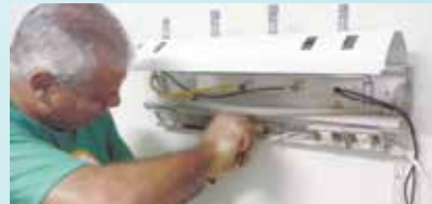
Reparo de filtro de gases no Hospital Silvério Fontes - Castelo
