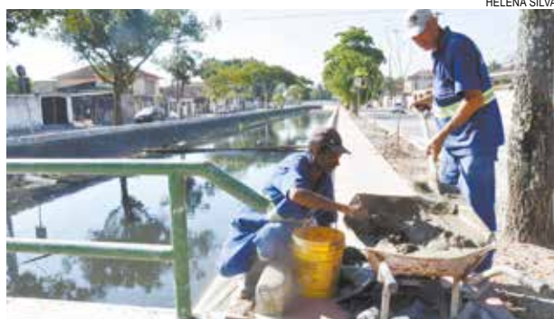
Operários atuam no paisagismo e recuperação de taludes
