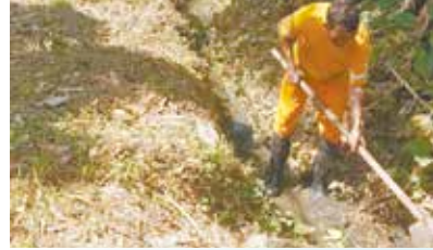
Limpeza de valas, ruas e acesso - Iriri
