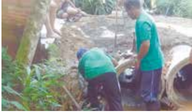
Instalação de manilhas no acesso às casas - Iriri
