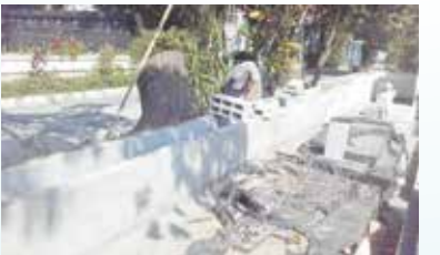
Reconstrução das muretas do Cemitério do Paquetá - Paquetá
