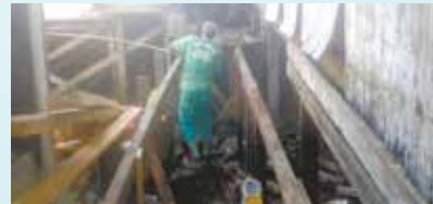
Continuação da recuperação das passarelas do Caminho da Capela - Rádio Clube
