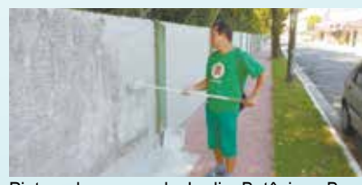
Pintura dos muros do Jardim Botânico - Bom Retiro
