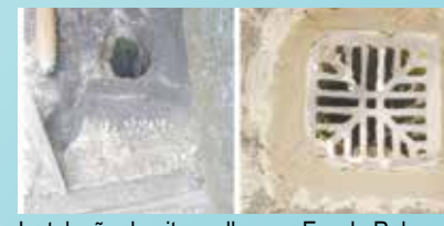
Instalação de oito grelhas na Escola Rubens Lara - Nova Cintra
