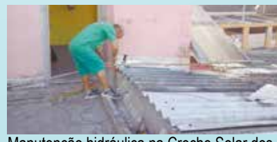
Manutenção hidráulica na Creche Solar dos Anjos - Nova Cintra
