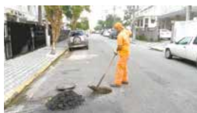
Limpeza de boca de lobo e poço de visita na Rua Arthur Porchat de Assis - Boqueirão
