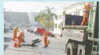
Continuação dos reparos no asfalto da Rua Bittencourt - Vila Nova
