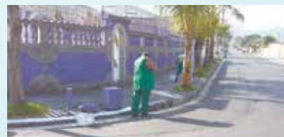
Pintura de guias e postes na Rua Maria Patrícia - Santa Maria
