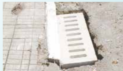
Troca de boca de lobo na Praça Iguatemi Martins - Vila Nova
