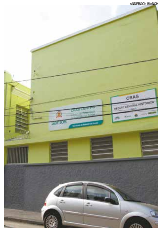
Cras ficará em imóvel na Rua Sete de Setembro, 47
