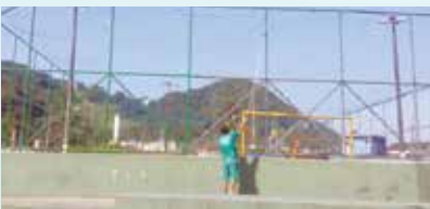
Pintura de tubos para colocação de alambrados na Praça Guilherme Délius - Alemoa
