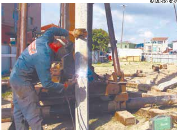
Trabalhadores já fincaram 57 estacas no solo a 28 metros
