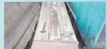
Continuação da recuperação da passarela do Caminho da Capela - Rádio Clube
