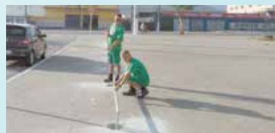
Concretagem de tubos para os painéis da área de skate na Av. Afonso Schmidt - Rádio Clube
