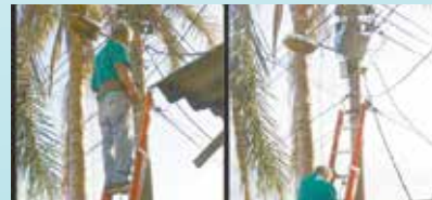
Instalação de refletor na Rua 1 - Pacheco
