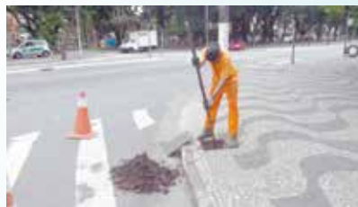
Limpeza de boca de lobo e poço de visita na Rua Felipe Camarão - Estuário
