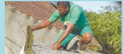
Limpeza de calhas na UBS da Penha
