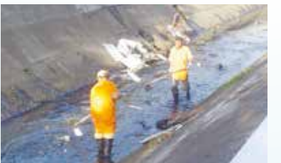
Continuação da limpeza do canal da Av. Campos Sales - Vila Nova
