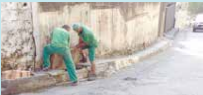
Manutenção de mureta na Rua São Cristóvão - São Bento
