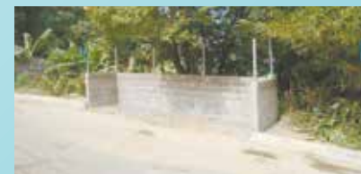
Continuação de obra para instalação de contentores - Santa Maria
