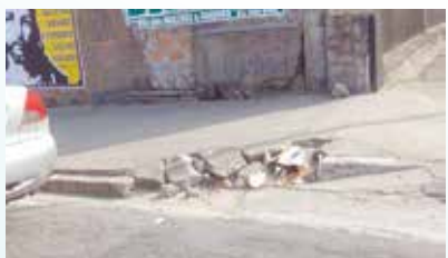
Reparo de guia na entrada da Arena Santos - Vila Mathias
