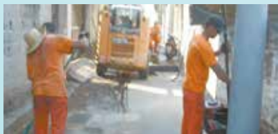
Pavimentação da Rua F - José Menino
