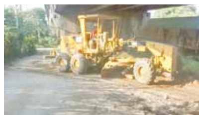
Limpeza, aterro para melhor escoamento de águas paradas debaixo do acesso ao elevador - Monte Cabrão
