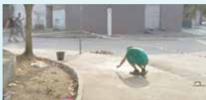
Concretagem do piso na Praça dos Ex-Combatentes - Rádio Clube
