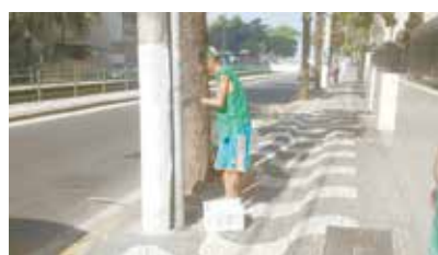
Pintura de postes no canal 5 - Aparecida
