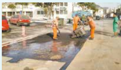
Reparo do asfalto na Rua Bittencourt - Vila Nova
