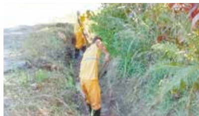
Limpeza de vala na Rua Antônio Mineiro - Caruara
