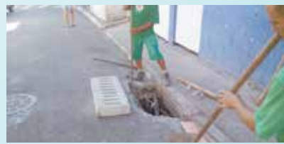
Troca de grelhas na Rua Brigadeiro Newton Braga - Saboó
