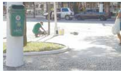
Pintura, colocação de lixeiras e reparos em mosaicos. Praça Rui Barbosa - Centro
