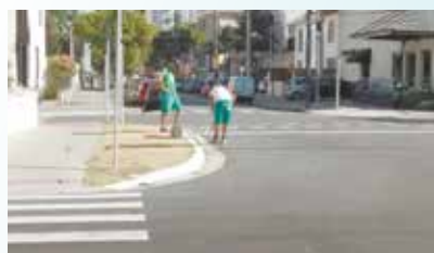
Pintura de postes e guias da Av. Almirante Cóchrane (canal 5) - Aparecida
