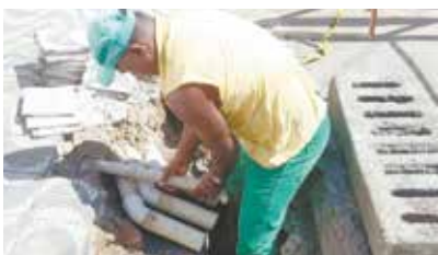
Abatimento e troca de grelha de boca de lobo na Rua Maria Máximo - Ponta da Praia
