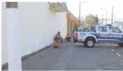
Pintura prédio da Guarda Municipal - Vila Nova
