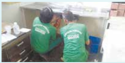
Fixação da pia da sala de emergência no Hospital Silvério Fontes - Castelo
