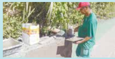
Reparo no muro da encosta do Morro do Pacheco
