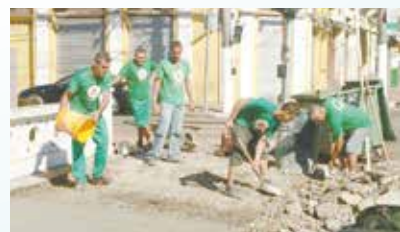
Calçada nova no canal da Avenida Campos Sales - Vila Mathias
