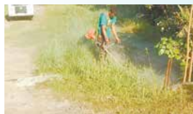
Roçada de mato na Rua Xavantes e Rua João Torres - Caruara
