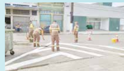
Demarcação do novo estacionamento na Praça Nagasaki - Vila Nova
