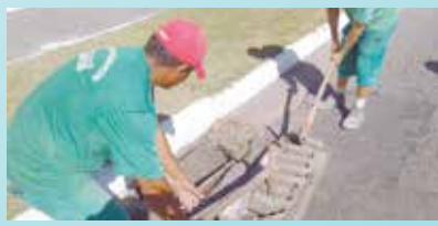
Troca de três grelhas de concreto na Av. Martins Fontes - Morro do Pacheco
