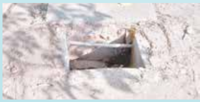
Execução de tampa na Lagoa da Saudade - Morro Nova Cintra
