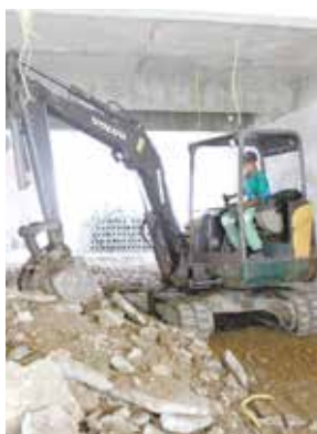
Operários escavam o piso do subsolo e trabalham no revestimento da área externa do edifício de três pavimentos
