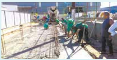
Concretagem de radier na Praça Guilherme Délius - Alemeia
