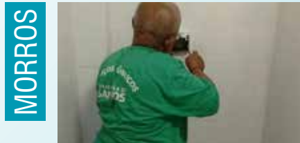
Instalação de canoplas hidra na Escola Rubens Lara - Morro Nova Cintra
