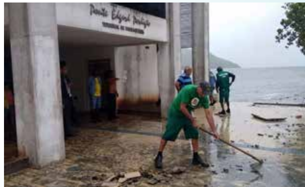
Limpeza Ponte Edgar Perdígão - Ponta da Praia
