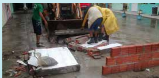
Retirada de entulhos na Vila Criativa - Rádio Clube
