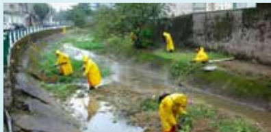
Limpeza do canal na Rua Maria Mercedes Féa - Saboó
