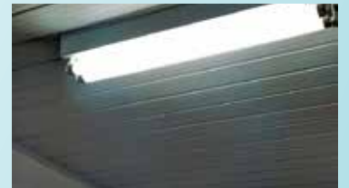
Instalação de luminárias na escola Rubens Lara - Morro Nova Cintra
