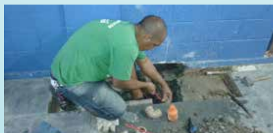
Reparo em tubulação rompida na UME Yara Santini - Castelo
