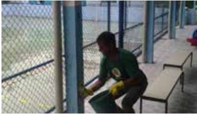
Lavagem no madeiramento do pátio da UME Monte Cabirão
