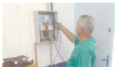
Instalação de novo quadro distribuição de energia, na sala de informática na UME Judoca Ricardo Sampaio - Caruara
