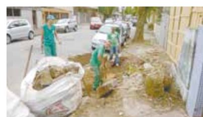
Reparo em calçada danificada por raízes de árvores na Rua Bezerra de Menezes - Estuário
