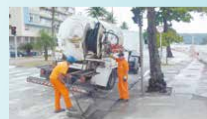
Desobstrução do sistema de drenagem - Ponta da Praia
