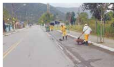
Capinação e limpeza da Rua Andrade Soares - Caruara
