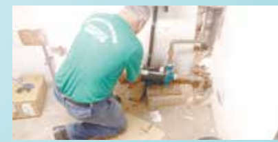
Substituição de moto bomba na UME Esmeraldo Tarquínio - Bom Retiro
