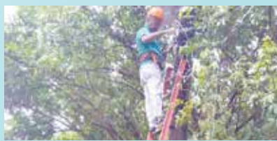
Instalação de refletores na Rua do Seminário - Morro Nova Cintra
