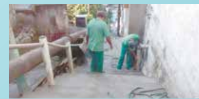
Continuação da manutenção da Escadaria São Domingos - Morro São Bento
