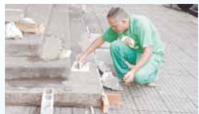
Manutenção da escada no Mercado Municipal - Vila Nova
