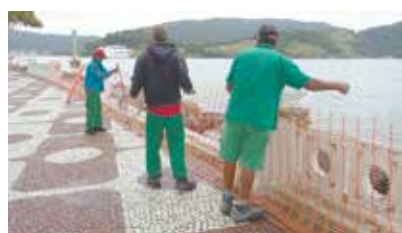
Isolamento dos trechos danificados na orla da Ponta da Praia
