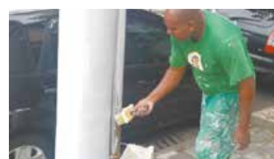
Pintura de postes na Avenida Pedro Lessa - Embaré
