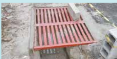
Início da manutenção de grelhas na Rua 7 - M. José Menino
