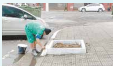
Pintura de guias e covas no entorno do Mercado Municipal - Vila Nova
