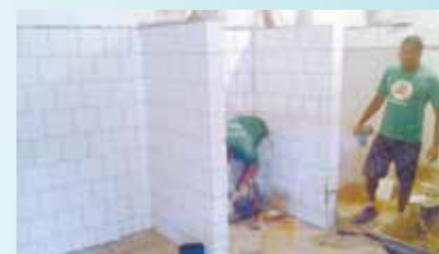
Aplicação de revestimento cerâmico e vestiário Sociedade Esportiva Caruará
