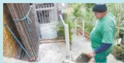
Instalação de corrimão na Rua 7 - Morro José Menino
