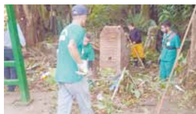
Limpeza e retirada de lixo na futura oficina de artesanato - Caruará
