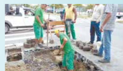
Reparo do abatimento da Rua Afonso Celso de Paula Lima x praia - Ponta da Praia
