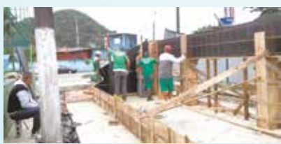
Madeiramento para concretagem de arquibancada na Praça Guilherme Delius - Alemoa
