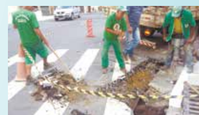
Reparo de abatimento na Av. Siqueira Campos com Rua Epitácio Pessoa - Embaré
