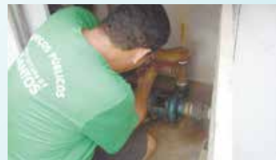
Substituição de motor na Seambesp - Vila Nova
