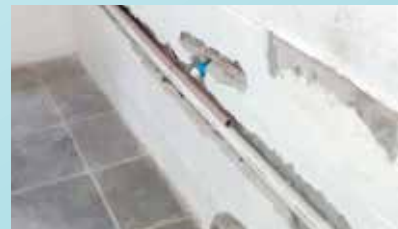
Início da instalação do bebedouro na Marina Magalhães - São Bento
