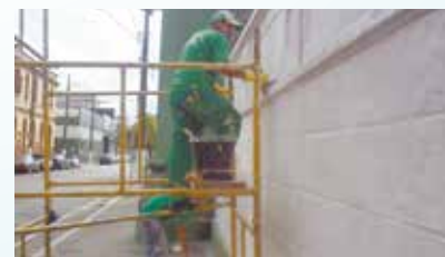
Pintura de postes e guias no Cemitério Paquetá
