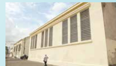
Pintura do prédio do Mercado Municipal - Vila Nova
