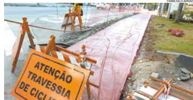
Obra já conta com cerca de 2,6 mil metros concluídos
