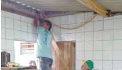
Madeiramento para instalação de forro em PVC da cozinha da Soc. Esportiva do Caruara
