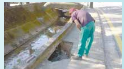
Reparo em Buraco da Av. Nilo Peçanha com Rua Carvalho de Mendonça - Marapé
