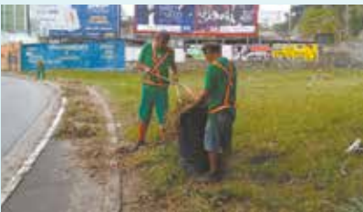
Limpeza e retirada de lixo no Viaduto Aristides de Bastos Machado
