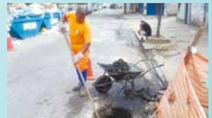
Limpeza de poços de visita e bocas de lobo na Rua Caminho São Jorge - Caneleira
