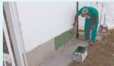
Pintura externa do SENAT - Bom Retiro
