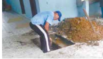
Reparo e desentupimento da caixa de gordura e fossa da UME Monte Cabrão
