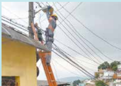
Reparo na iluminação na Rua das Pedras - Caneleira
