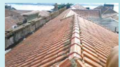
Troca de telhas e cumieiras prédio da Procuradoria Fiscal - Centro
