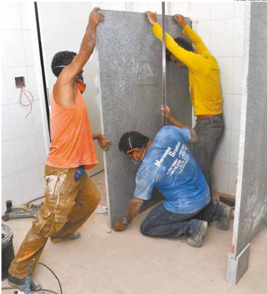
Instalação de divisórias de granito nos vestiários é um dos serviços em andamento
