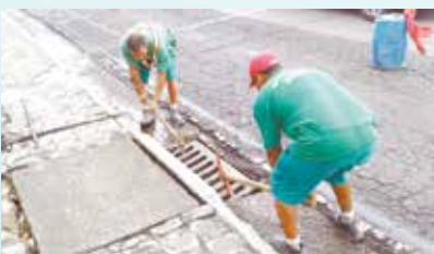
Continuação da troca de grelhas na Av. Martins Fontes - Saboó
