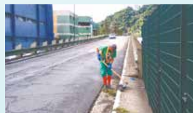
Limpeza e retirada de mato na descida do Elevado Aristides de Bastos Machado
