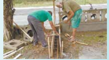
Baldrame para execução da mureta na Sociedade Esportiva Caruara
