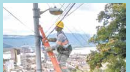
Reparo nas luminárias - Monte Serrat
