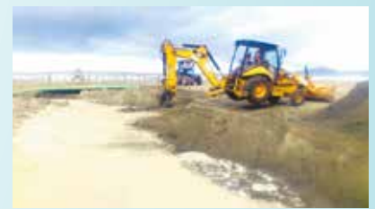
Retirada de areia dentro e no entorno do canal 3 - Gonzaga
