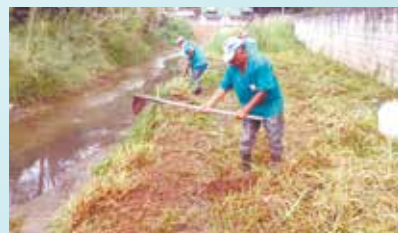
Limpeza e roçada nas margens do canal atrás da UME 28 de Fevereiro - Saboó
