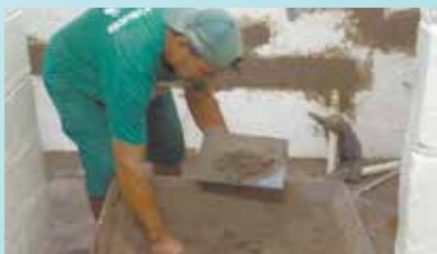
Reparo em paredes no Complexo Esportivo Marina Magalhães - São Bento
