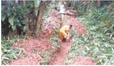
Desobstrução das valas na marginal na frente das chácaras - Caruara
