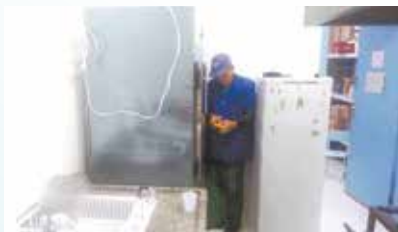
Conserto na parte elétrica da Escola Irmã Maria Dolores - Vila Nova
