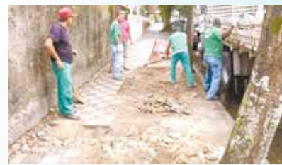
Reparo em calçada danificada por raízes de árvore - Gonzaga
