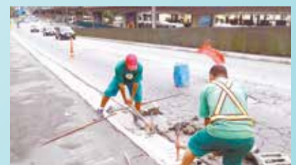
Troca de grelhas no Elevado Aristides de Bastos Machado
