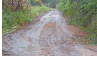
Nivelamento nas ruas Principal e Pedrosa - Iriri
