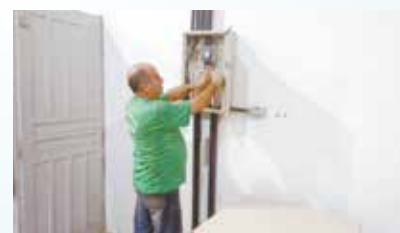
Troca de disjuntor na Sefin Banco do Brasil - Centro
