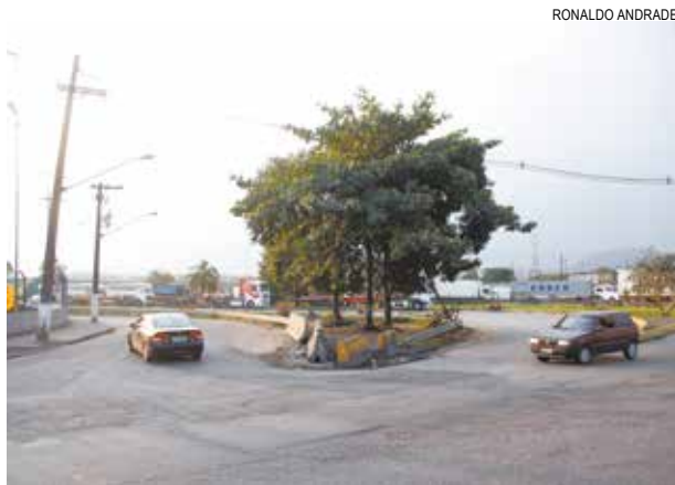
Trabalhos visarão melhorar a mobilidade e drenagem
