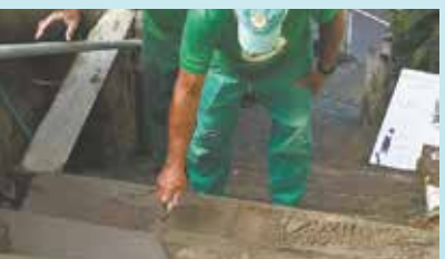
Continuação da manutenção de escadaria São Domingos - Morro São Bento
