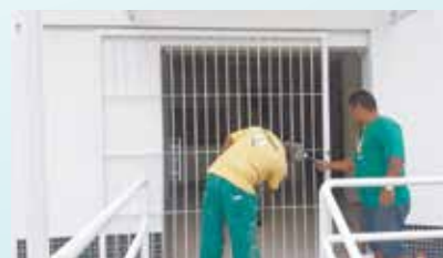
Pintura de grades, corrimão e portões no Senat - Bom Retiro
