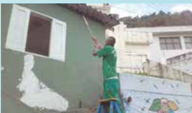
Pintura externa na Sociedade de Melhoramentos - Monte Serrat
