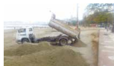
Colocação de areia na praia - Ponta da Praia
