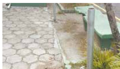
Instalação de tubos galvanizados para posterior colocação de tela alambreado - Monte Cabrão
