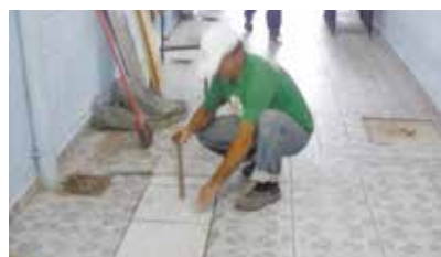
Reposição de piso cerâmico na UME Monte Cabrão
