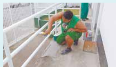
Pintura de corrimão e grades do Senat - Bom Retiro
