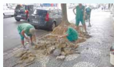
Reparo em calçada danificada por raízes de árvores na Rua Saturnino de Brito - Marapé
