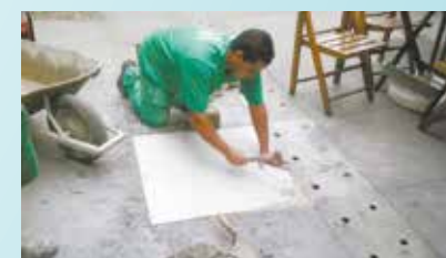
Troca de grelha e piso do bulevar da Rua XV - Centro
