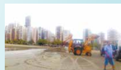
Retirada de areia no entorno do canal 2 - Pompeia
