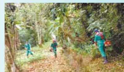
Roçada de mato no valão da Rua Caramuru e Rua Castelo Branco - Caruara
