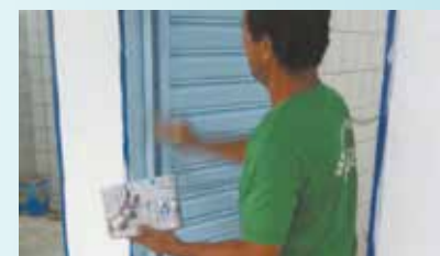
Pintura de portas, reboco das muretas e nivelamento para posterior cimentado da área externa na Sociedade Esportiva de Caruara
