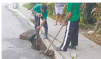
Desobstrução na galeria de águas pluviais na Pça. Encarnacion Alves Corpas - Caruara
