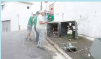
Retirada e colocação de lixeira na Rua Amália com Av. Brasil - Morro Vila Progresso
