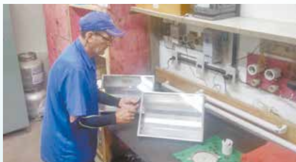
Manutenção nos refletores da UME José Bonifácio - Vila Nova
