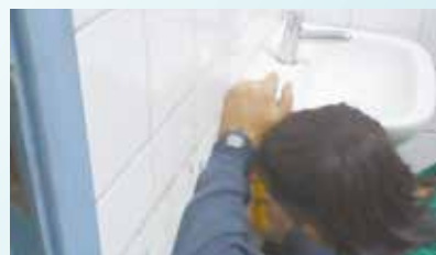
Retirada de lavatório quebrado - UME Mário de Almeida Alcântara - Valongo
