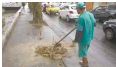
Reparo na calçada da Av. Washington Luis - Boqueirão
