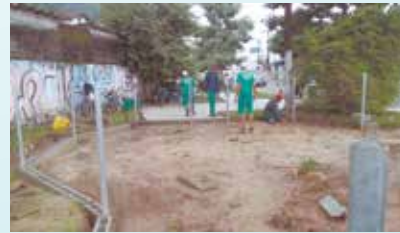
Continuação do chumbamento dos tubos de alambrado na Pça. Albertino Moreira - Caneleira
