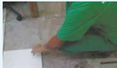
Colocação de piso da copa do Paço Municipal - Centro
