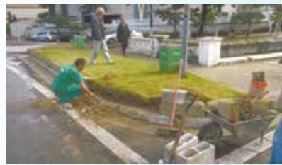
Manutenção das guias do jardim da Av. Afonso Pena com o canal 6 - Aparecida
