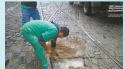
Recolocação de paralelos na Rua do Comércio - Centro
