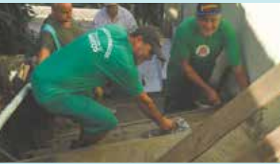
Continuação de manutenção da Escadaria São Domingos - São Bento
