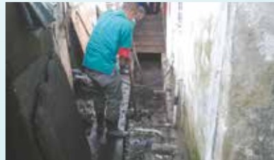
Limpeza de canal na margem direita do Beco 194 - Alemoa
