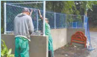
Instalação de alambrado e pintura dos tubos na Rua 1 - Santa Maria
