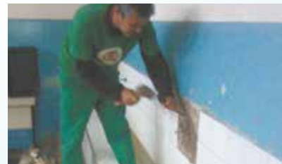
Colocação de azulejos no lavatório da UME Maria Helena Roxo - Vila Mathias
