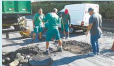
Renovimento de PV na Av. Martins Fontes - Sabóó
