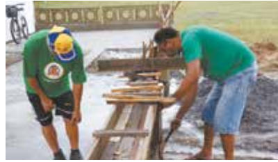
Madeiramento das colunas da mureta da Sociedade Esportiva de Caruara
