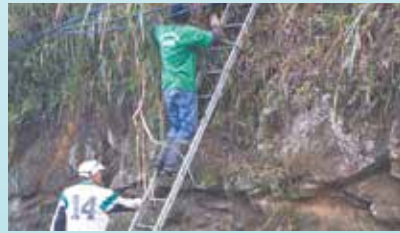
Corte de grama na Rua das Pedras - São Bento
