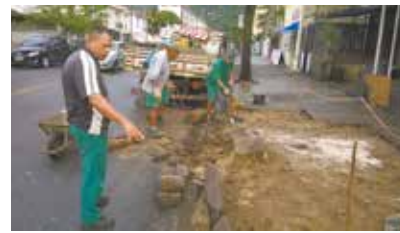
Manutenção da calçada danificada por raízes de árvores na Rua Ana Nery - Marapé
