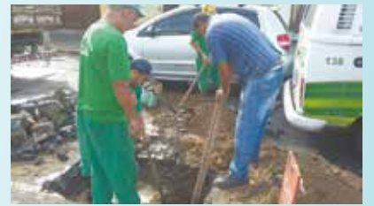
Reparo em abatimento na Rua Oswaldo Cruz - Boqueirão
