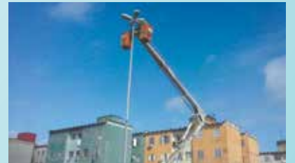
Revisão na iluminação externa do Complexo Esportivo Dale Coutinho - Castelo
