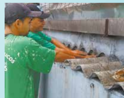
Troca de madeiramento e colocação de rufos na Creche Irmã Maria Dolores - Paquetá
