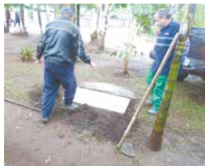
Reparo e troca de caixa de esgoto na Pça. Encarnacion Alves Corpas - Caruara
