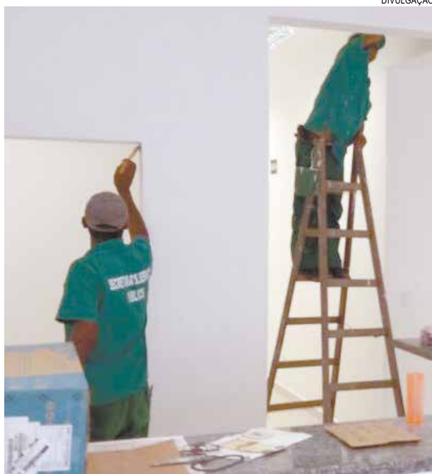
Prédios recebem retoques de pintura e outros serviços
