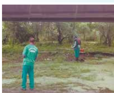
Roçada de mato na Rua Principal debaixo do elevador do Monte Cabrão
