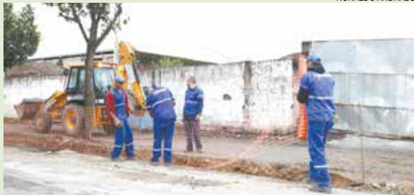
Trabalhos iniciaram com a demolição de sarjetas
