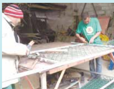
Execução de painéis para fechamento da área de skate na Av. Afonso Schmidt - Rádio Clube
