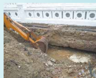
Reparo em abatimento no calçadão da mureta no canal 2, trecho da praia - Pompeia
