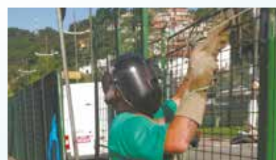
Colocação de grades na descida do elevador Aristides Bastos - Bairro Chinês
