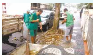
Reparo em calçada danificada por raízes de árvores na Rua Sampaio Moreira - Aparecida
