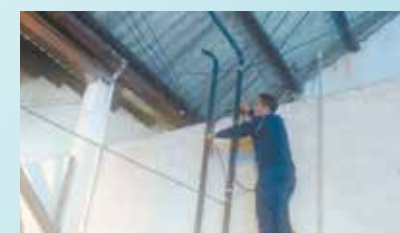
Instalação de refletores na Cotran - Vila Mathias
