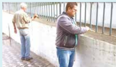
Aplicação de zarcão no gradil da piscina do Centro Esportivo M. Nascimento - Bom Retiro
