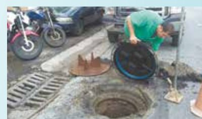
Troca e renivelamento de poço de visita na Av. Bartolomeu de Gusmão - Aparecida
