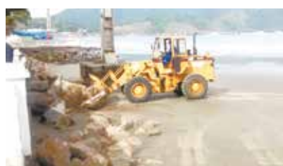
Colocação de enrocamento de pedras na praia da Ponta da Praia
