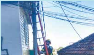
Reparo nas luminárias - Jabaquara
