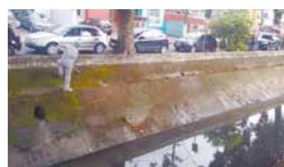
Lavagem do talude no canal 3 x Joaquim Távora
