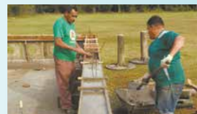
Concretagem da mureta, assentamento de banco na Sociedade Esportiva de Caruara
