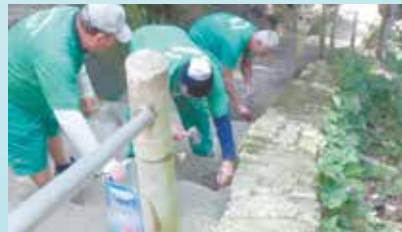
Recuperação de guarda-corpo na Vila Baiana - José Menino
