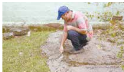
Reparo na caixa de fossa e esgoto da UME Noel Gomes Ferreira - Caruara
