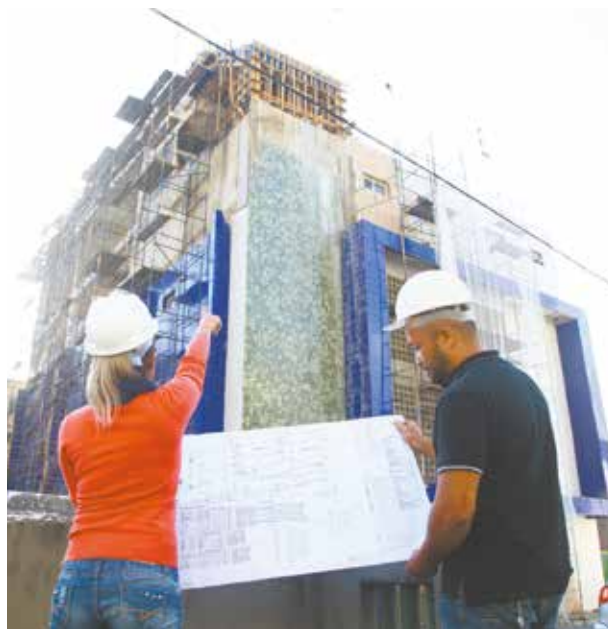
Concretagem da estrutura do prédio está concluída
