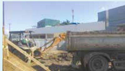
Demolição de piso na Praça Guilherme Delius - Chico de Paula
