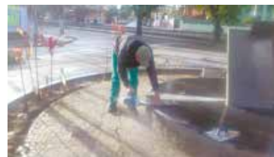
Manutenção da Praça André Di Fazio - Marapé
