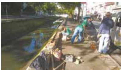
Reparo em mureta do canal na Rua Joaquim Távora x Canal 2 - Vila Belmiro
