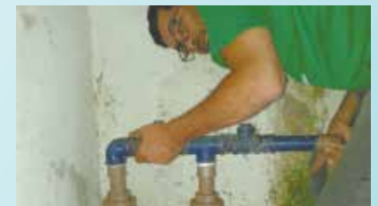
Troca de duas moto-bombas na UME Mário de Almeida Alcântara - Valongo
