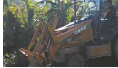
Retirada de entulho e lixo na Rua Principal - Monte Cabrão
