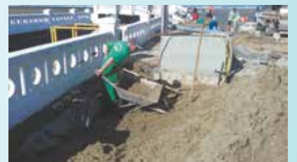
Reparo em abatimento no calçadão da praia ao lado do Canal 2 - Pompeia
