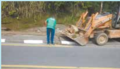
Retirada de entulho proveniente queda de barreira, na Rua São Cristóvão - São Bento
