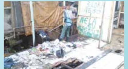
Limpeza no Rio Furado - Alemoa
