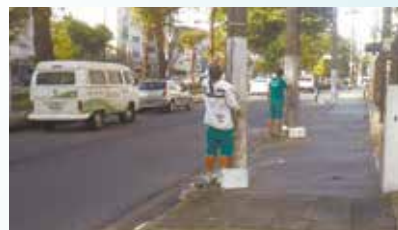
Pintura de postes e guias da Av. Washington Luís
