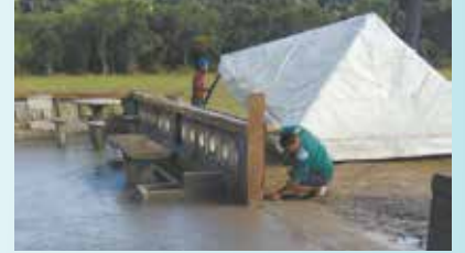
Cimentado da área externa e montagem de tendas na Sociedade Esportiva de Caruara
