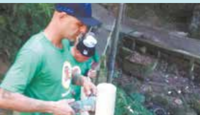
Colocação de tubos de ferro e finalização do corrimão da Vila Baiana - J. Menino
