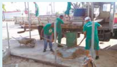
Reboco das muretas de fechamento do playground na Praça Albertino Moreira - Caneleira
