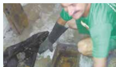
Serviço em caixa de gordura Seacolhe AIF - Rua Bittencourt - Vila Nova
