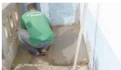
Cimentado da área externa da Sociedade Esportiva de Caruara
