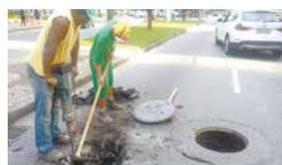
Reparo em abatimento na Av. Bartolomeu de Gusmão - Boqueirão
