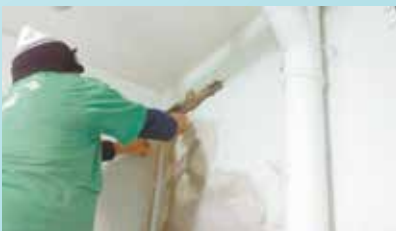
Reparo na hidráulica do banheiro na regional - Nova Cintra
