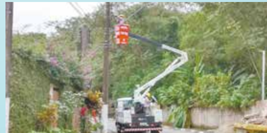
Manutenção na Rua Adilson Buló - Nova Cintra
