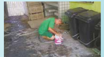
Limpeza e desobstrução da caixa de gordura na Rua 7 de Setembro - Vila Nova
