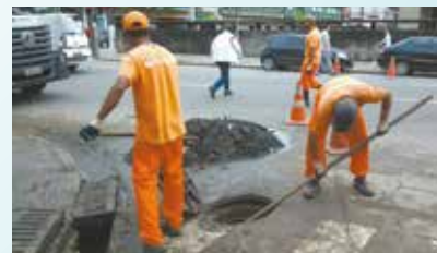
Limpeza de poços de visita no sopé da Rua Tiro Naval - Vila Nova
