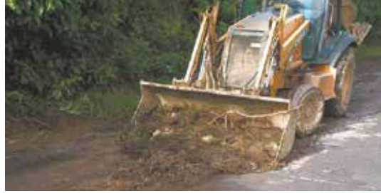
Retirada de entulho na Rua Principal - Monte Cabrão
