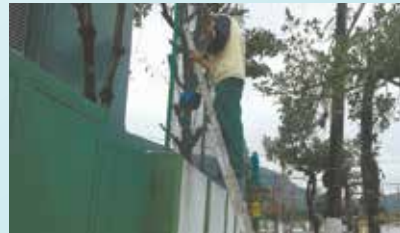
Pintura da estrutura do alambrado na UBS Bom Retiro
