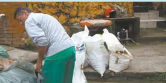
Carregamento de material para escadaria na Vila Baiana - J. Menino
