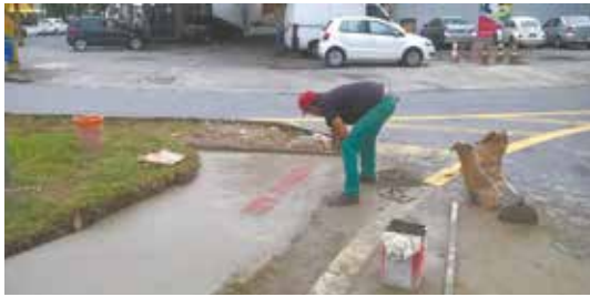
Manutenção da Praça Gomide Ribeiro - Embaré
