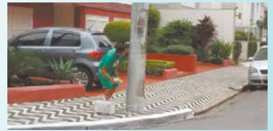
Pintura de guias e postes na Rua Azevedo Sodré - Boqueirão
