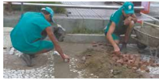
Manutenção do piso em mosaico - Ponta da Praia
