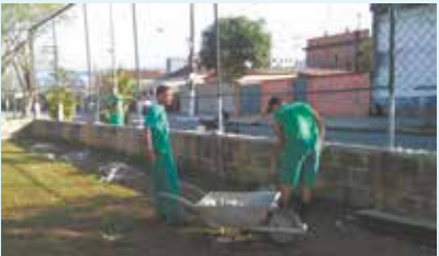
Demolição e limpeza na Praça Euzébio Rocha - São Manoel
