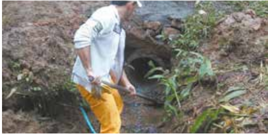
Instalação de manilhas e limpeza na Rua Marginal - Caruara
