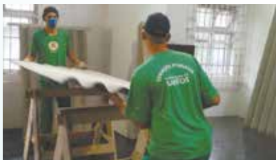
Colocação de telhas no Espaço Querô - Vila Mathias
