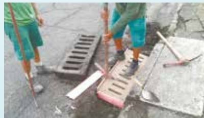
Troca de grelhas na Av. Martins Fontes - Saboó
