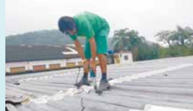
Reparo no telhado da UBS Vila São Jorge - Caneleira
