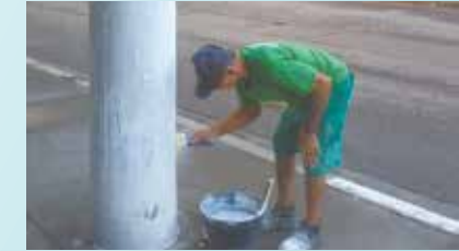
Pintura de postes e guias na Rua Martim Afonso - Centro
