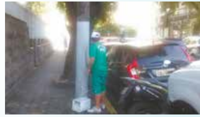
Pintura de guias e postes na Rua Mato Grosso - Boqueirão
