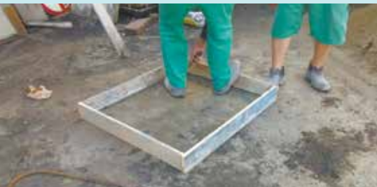
Confecção de tampas de drenagem para a Escadaria 9 de Julho - Marapé
