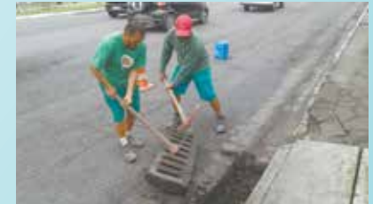
Troca de grelhas na Av. Getúlio Vargas
