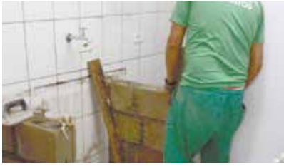
Base de alvenaria para instalação de pia no Cecom - Caruara
