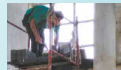
Serviços de alvenaria nas paredes internas do instituto Querô - Vila Nova
