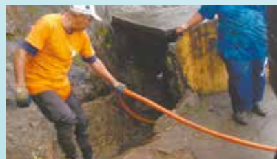
Drenagem desobstruída - Santa Marta
