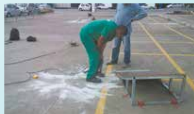
Início da colocação dos obstáculos de skate na Av. Afonso Schmidt - Rádio Clube
