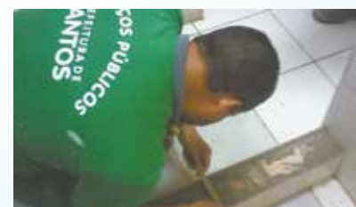
Colocação de box de banho para os funcionários do Detic - Centro
