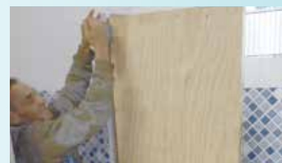
Troca de porta do banheiro na UME Judoca Ricardo Sampaio - Caruaru
