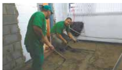
Colocação de piso na UME Iveta Mesquita Nogueira - Ponta da Praia
