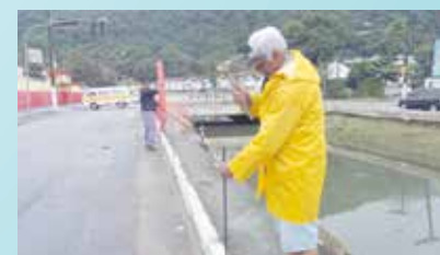
Isolamento de trecho da mureta do canal na Rua Francisco Ferreira Canto
