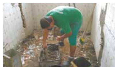
Reforma do banheiro do Seabrigo - Boqueirão
