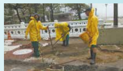
Reparo no piso no calçadão ao lado do canal 2 - Pompeia
