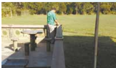
Reboco da mureta. Sociedade Esportiva de Caruara.
