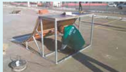
Colocação de equipamentos para skate na Av. Afonso Schmidt - Rádio Clube
