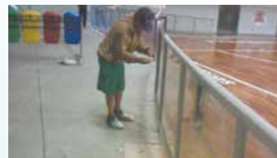
Pintura do guarda-corpo da quadra da Arena Santos - Vila Mathias
