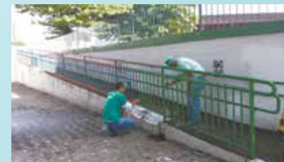
Pintura do gradil no Centro Poliesportivo M. Nascimento - Santa Maria
