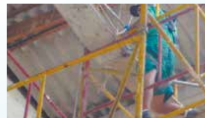
Reparos no telhado instituto Querô - Vila Nova
