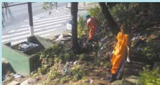
Limpeza de drenagem na Rua 1 - Boa Vista
