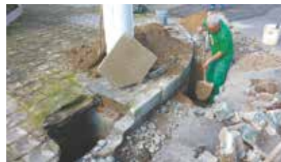
Implantação de boca de lobo na rua Alfaia Rodrigues com Rua João de Barros - Aparecida
