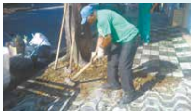
Manutenção de calçadas danificadas por raízes de árvores na Rua Nabuco de Araújo
