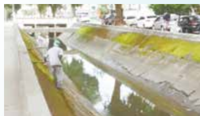
Manutenção do talude do Canal 3 - Boqueirão
