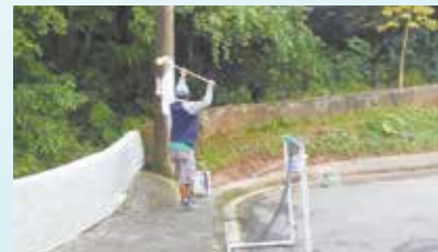
Pintura da mureta da encosta do Ilhéu Baixo
