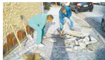
Manutenção de calçadas na Rua Imperatriz Leopoldina - Ponta da Praia
