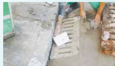
Substituição de grelhas de bocas de lobo na Avenida Senador Feijó - Vila Mathias
