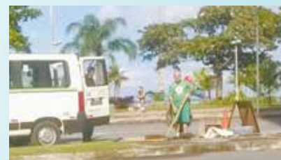
Reparo em boca de lobo na Av. Presidente Wilson, próximo ao canal 2 - José Menino
