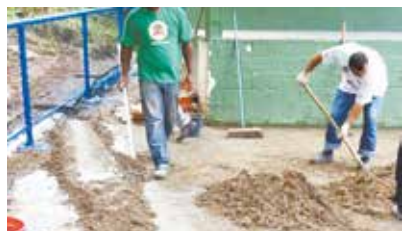
Cimentado no piso da Praça - Monte Cabrão
