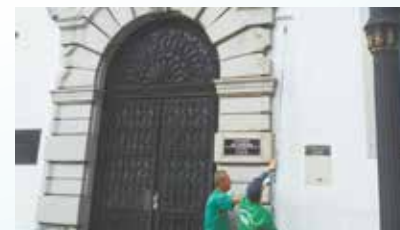
Pintura da parte externa do prédio do Pantheon dos Andradas
