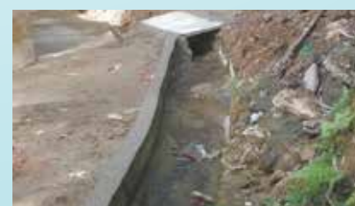
Reboco em mureta para condução de água pluvial no Beco da Policlínica - José Menino
