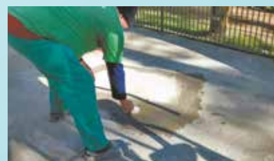
Reparo em caixa de passagem na Lagoa da Saudade - Nova Cintra
