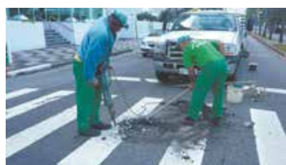
Renovimento de tampa de poço de visita na Av. Vicente de Carvalho com Rua Carlos Afonseca
