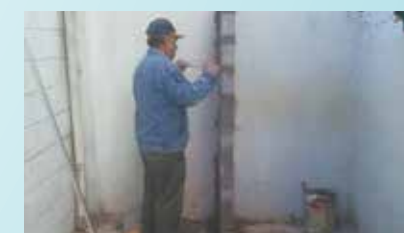
Construção de abrigo de gás Seacolhe - Rua Bittencourt - Vila Nova
