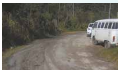
Nivelamento no acesso ao Monte Cabrão
