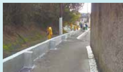
Pintura de muretas, postes e guias no Ilhéu Baixo
