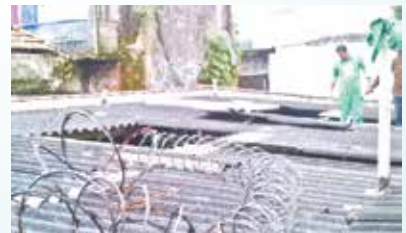
Troca de telhas na Seacolhe Seas - Vila Nova
