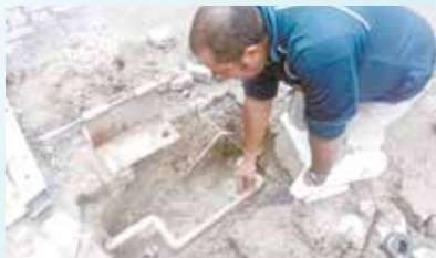
Conserto hidráulico na Arena Santos - Vila Mathias
