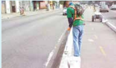
Pintura de guias e postes da entrada da Cidade
