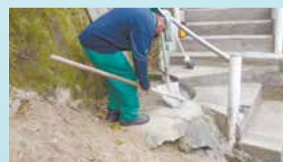
Continuação da manutenção da escadaria São Domingos - São Bento
