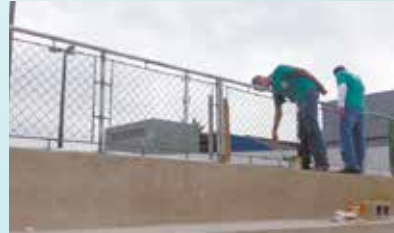
Instalação de alambrado na arquibancada na Praça Guilherme Délius - Vila Haddad
