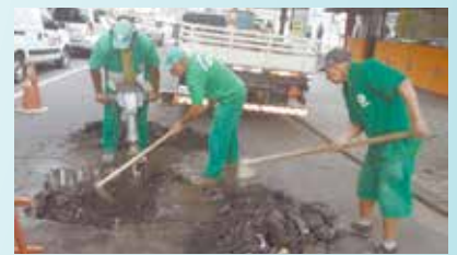
Reparo em abatimento na Av. Afonso Pena
