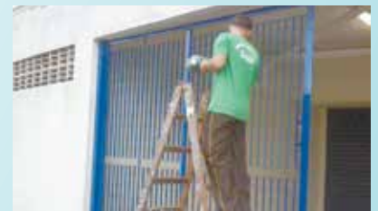
Pintura das grades do sub solo na Arena Santos - Vila Mathias
