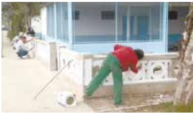
Lixamento e pintura da mureta da Sociedade Esportiva de Caruara
