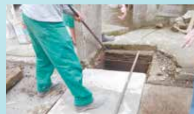
Desobstrução de drenagem na Rua 9 de Julho - Marapé
