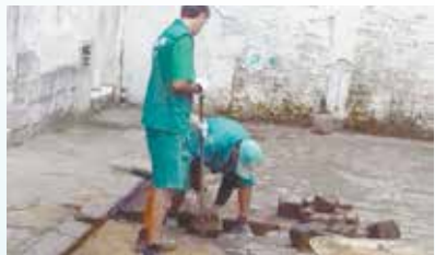
Renivelamento de paralelos na Rua Chile - Vila Nova
