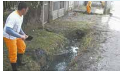
Desobstrução e limpeza da vala de drenagem da Rua Xavantes - Caruara
