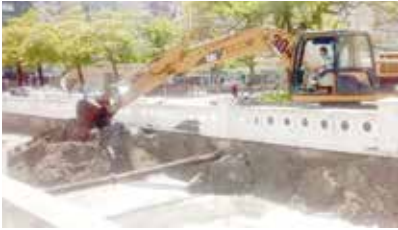
Remanejamento de areia do canal 2 - Pompeia
