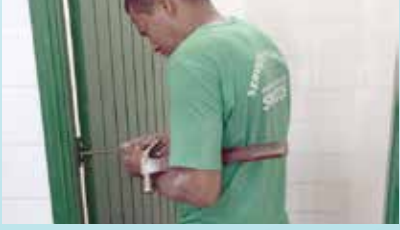
Recuperação de banheiros da Lagoa da Saudade - Nova Cintra
