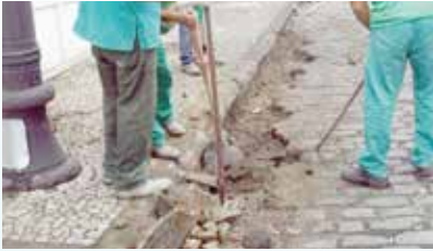
Rebaixamento de guia na Rua Comendador Neto - Centro
