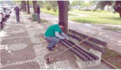
Pintura dos equipamentos urbanos da orla da praia
