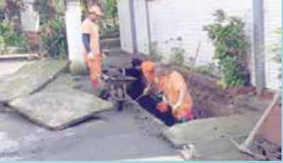
Limpeza de rede de drenagem na Rua Coronel Galhardo - Nova Cintra
