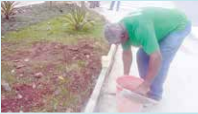
Reurbanização da praça da Avenida Siqueira Campos com Rua Cons. Lafayette - Embaré
