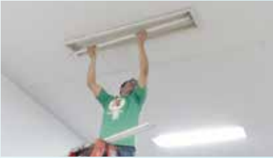
Troca de lâmpadas no Detic na Rua Itororó - Centro
