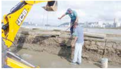
Manutenção das muretas em pedra na saída do canal 4, trecho da areia da praia - Embaré
