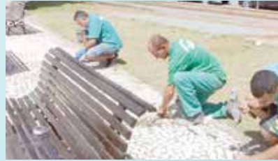
Assentamento de piso mosaico português na Praça dos Andradas - Centro
