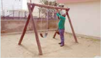
Colocação de correntes no balanço na Avenida Afonso Schmidt - Rádio Clube
