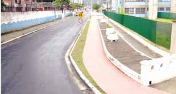
Faltam apenas 5% dos serviços para o fim da obra, que engloba várias melhorias na avenida > PÁG. A3
