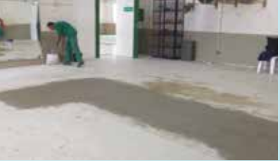
Conserto do piso da academia de ginástica no Centro Esportivo da Zona Noroeste - Castelo
