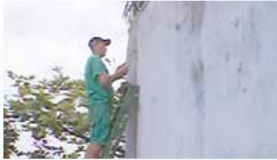
Reparo na caixa d'água do Centro de Capacitação Darcy Ribeiro - Vila Mathias
