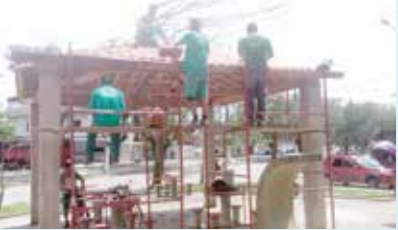
Cobertura de quiosque na Praça Otávio Ribeiro de Araújo - São Jorge
