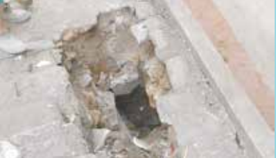
Reparo em escadaria na Rua Santa Joana D'Arc - São Bento
