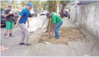
Reparo em calçada danificada por raízes de árvores na Rua Júlio Conceição - Encruzilhada
