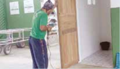
Continuação da substituição de portas do banheiro no Cemitério Filosofia - Saboó
