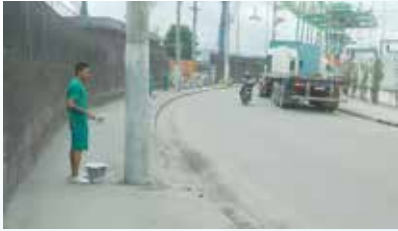
Pintura de postes na Rua Cristiano Ottoni - Valongo
