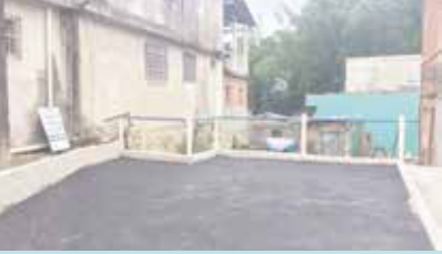
Asfalto na Rua 7 - Santa Maria
