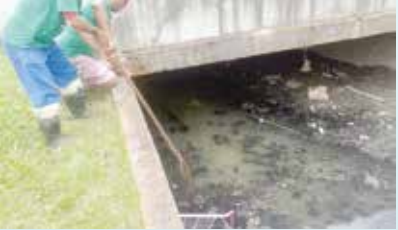
Limpeza de canal na Rua Flaminio Levy - Saboó
