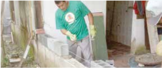
Edificação de paredes da futura oficina de artesanato - Caruara
