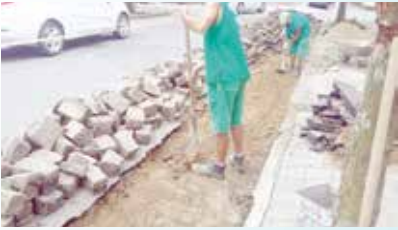
Renivelamento de sarjeta na Rua Pasteur - Gonzaga
