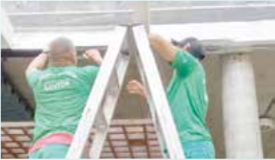
Reparo na calha da claraboia do Teatro Guarany - Centro
